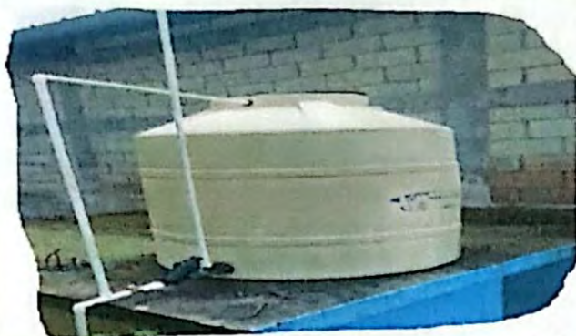
Foto 1: Sustitucion de deposito de agua
