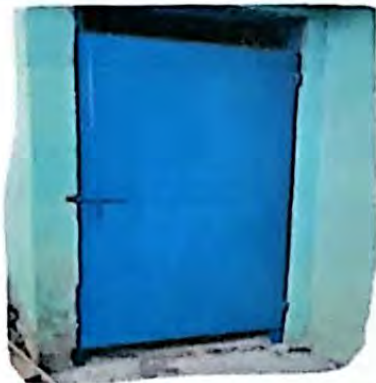
Foto13: Sustitución de puerta
