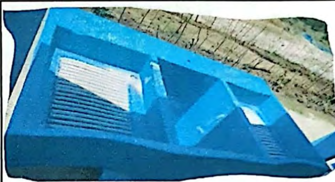
Foto 10: Sustitucion de pila
