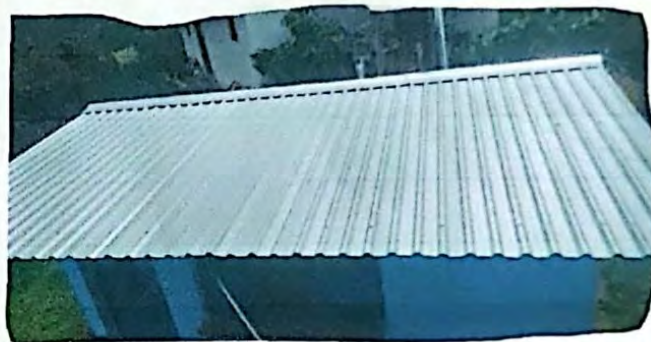
Foto 4: Sustitucion de techo
