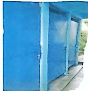
Foto 2: Sustitucion de puertas de baños
