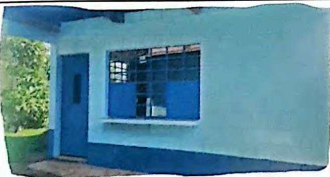
Foto 5: Sustitucion de ventanas
