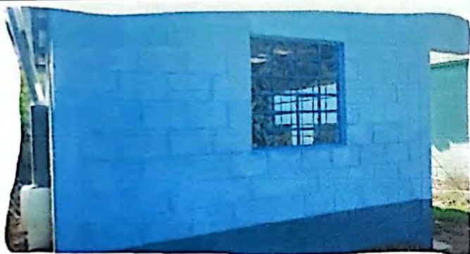
Foto 3: Sustitucion de pinturas exteriores
