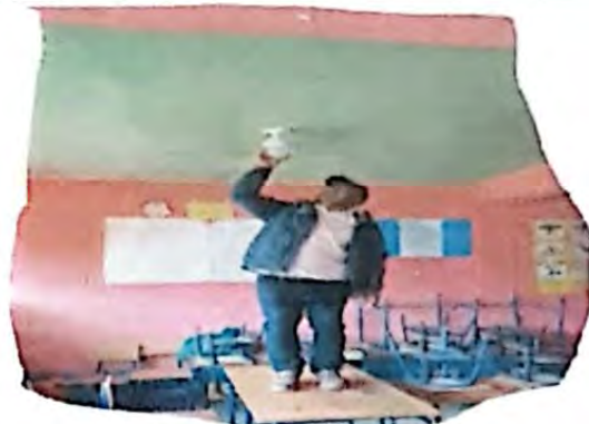
Foto13: Cambio de focos
