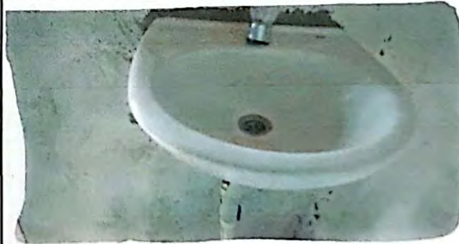
Foto 6: Sustitucion de lavamanos
